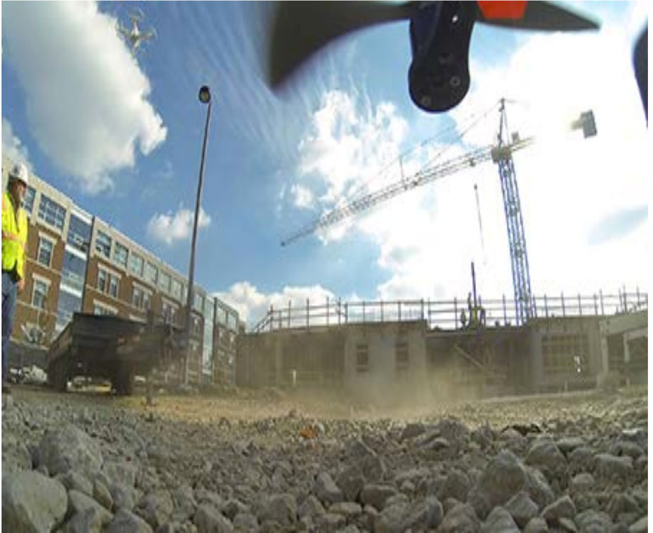
Figura 43 - Monitoramento de construções por drones
