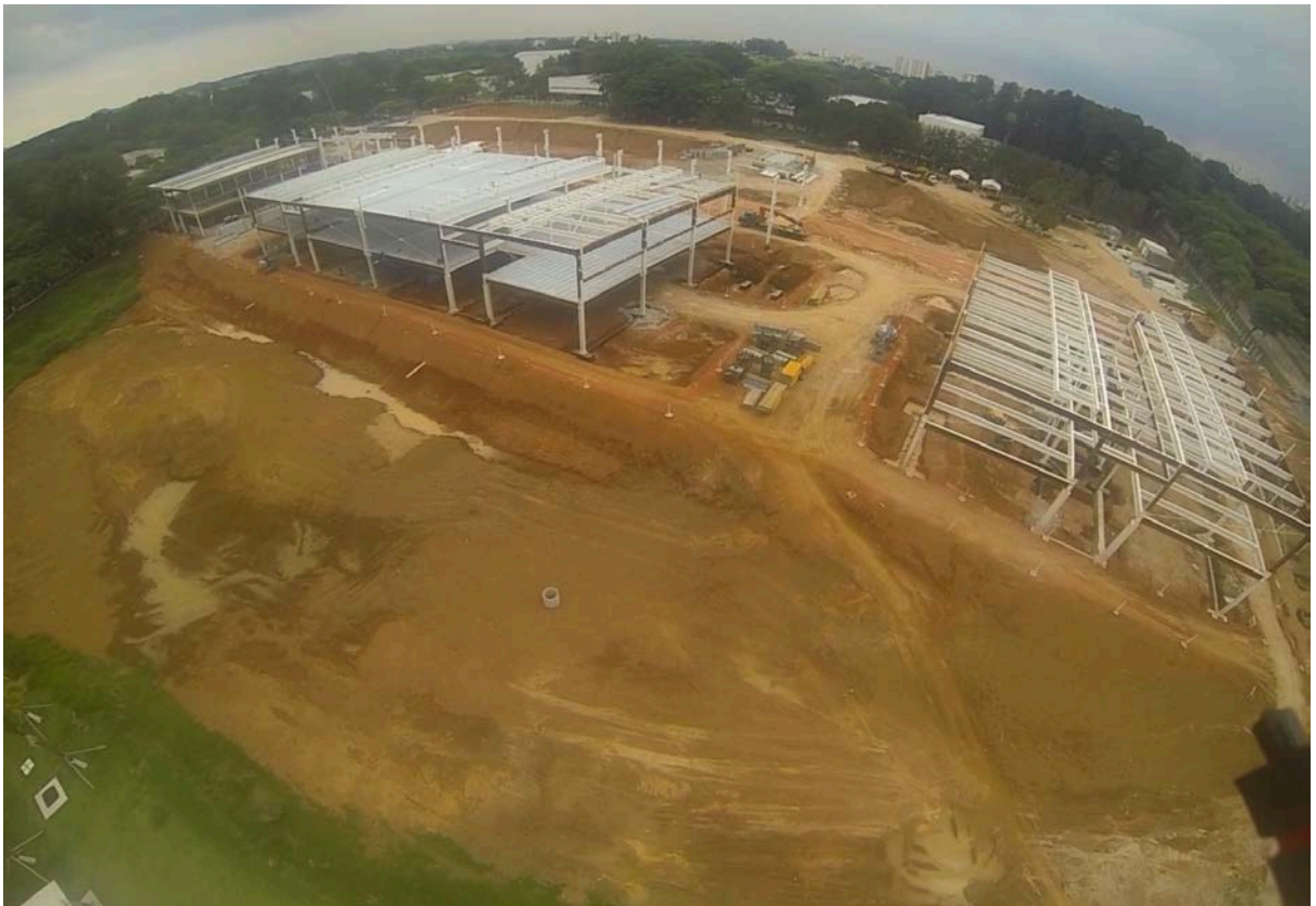
Figura 52 - Imagem obtida pelo hexacóptero (visão geral da construção)
